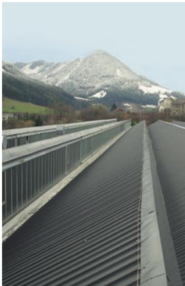
Das wärmedämmte Dach der Fertigungshalle.
