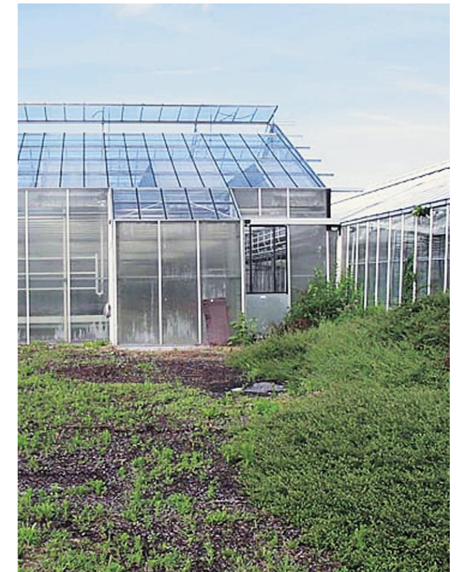
Die zusätzliche Isolation der Außenwände mit Noppenfolie reduzierte den Energieverbrauch beträchtlich.
