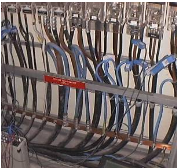
Abb.23: Meßaufbau für die Vielkanalige Lastganganalyse in der Praxis
