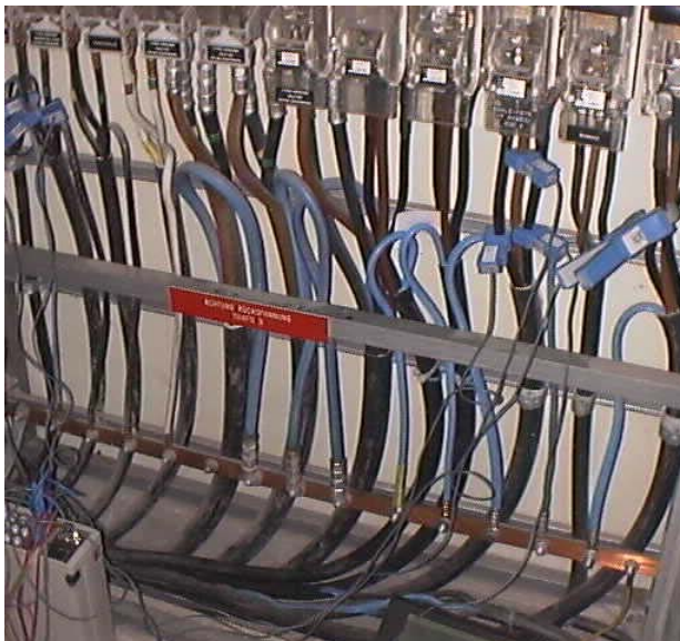
Abb.16: Messaufbau für die vielkanalige Lastganganalyse in der Praxis
