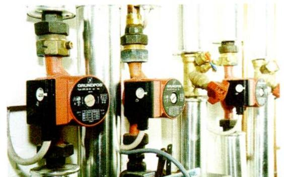
Manchmal ist jedoch nicht nur durch falsche Einstellung der Pumpe ein Mehrverbrauch an elektrischer Energie vorhanden. Auch die Strömungsgeschwindigkeit in den Rohren kann zu groß sein. Damit ergibt sich aber auch das Problem, daß die Temperaturspreizung zwischen Vor- und Rücklauf zu gering wird.
