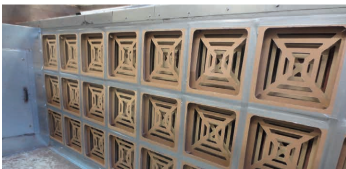
www.siemens.com/presse / Highlight: Trockenfilteranlage im Obj. 214
