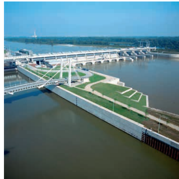
Komplette elektromechanische Ausrüstung für Großwasserkraftanlagen – Donaukraftwerk Freudenu, Österreich
