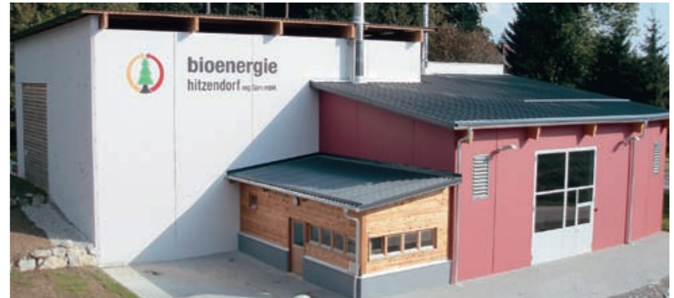
... eine Biomasse-Nahwärmeversorgung in Hitzendorf.
