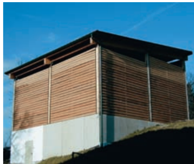
... die Biomasse-Nahwärmeversorgung der Familie Ocherbauer in Steirisch Tauchen und ...
