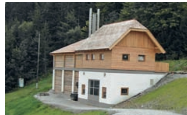
Projekte aus dem Hause Riebenbauer: das Biomasseheizwerk auf der Brandlucken, ...
