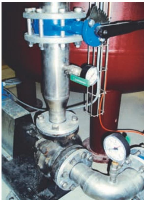
Umwälzpumpe für den internen Wasserkreis, der den Ammoniakkreislauf der Kälteanlage vom Trinkwasserkreislauf trennt.
