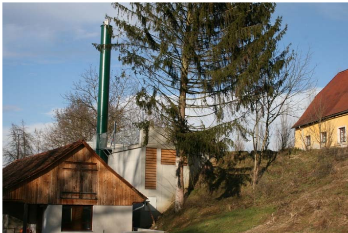
Heizhaus mit Hackgutlager
