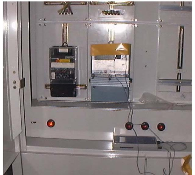
Abb.16: Messaufbau für die vielkanalige Lastganganalyse in der Praxis
