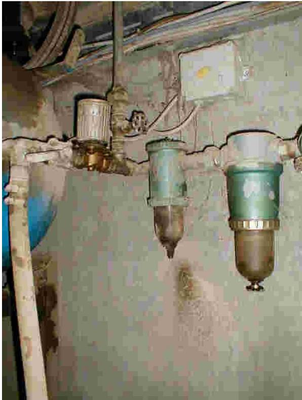
*Bild 13 : sichtbare Leckage an einem Öler*
