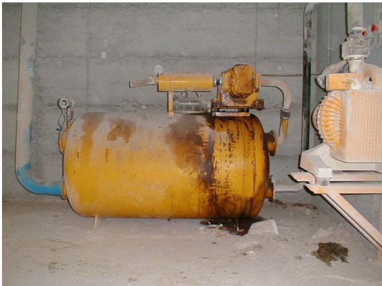
*Bild 14 : deutlich hörbare Leckagen an Übergängen und Verbindungen*
