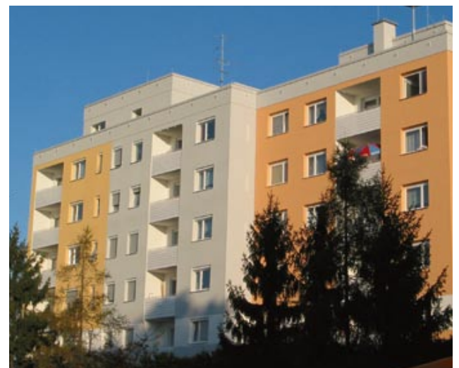
Dank der Sanierung konnte der Energiebedarf der Wohnanlage halbiert werden.
