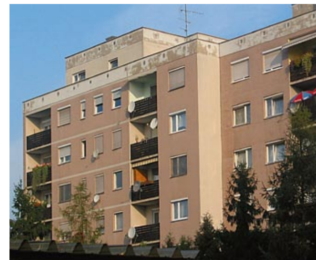
Die alten Fenster und Balkontüren wurden im Rahmen der Sanierung ausgetauscht.
