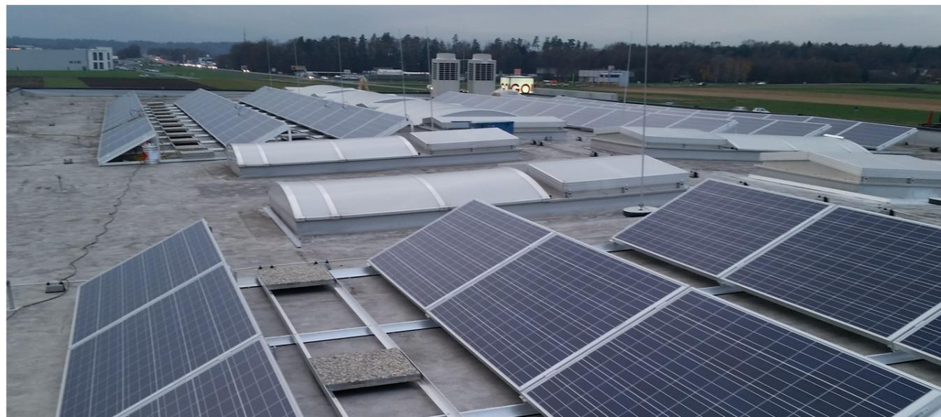
Die 20 kWp Photovoltaikanlage zur Eigenstromerzeugung deckt ein Drittel des Unternehmens mit Sonnenenergie ab und liefert 22.300 kWh/Jahr.
