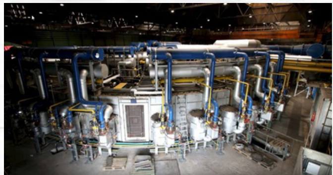
Drehherdofen nach dem Umbau
